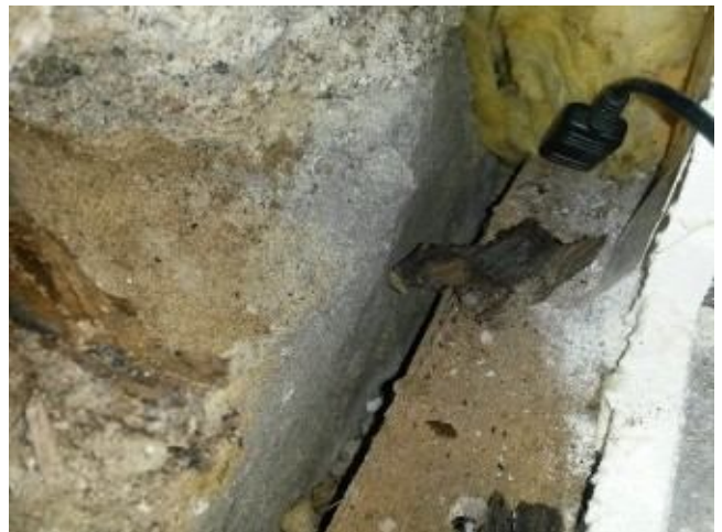
Puukoolattu seinärakenne. Surritappi lahonnut
