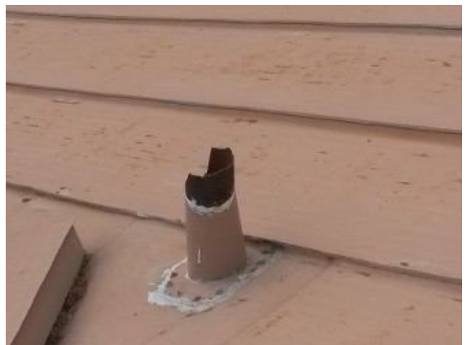
Tuuletusputken pää haljennut
