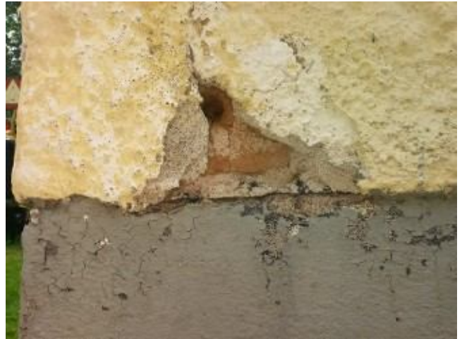
Seinästä lähtenyt palanen. Tiilirakenne näkyvissä.
