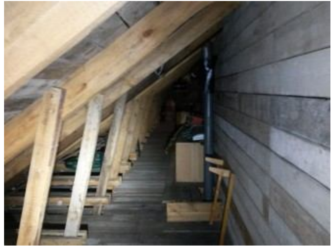
Sivuvinttiä. Viemärin tuuletusputki eristämättä
