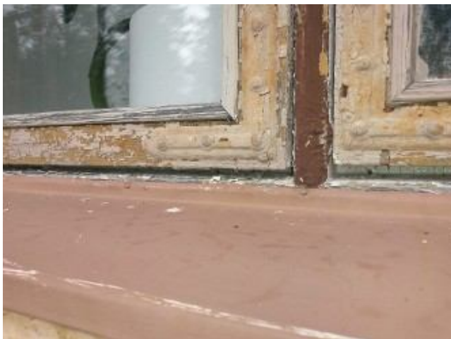
Ikkunan maalipinta hilseilee
