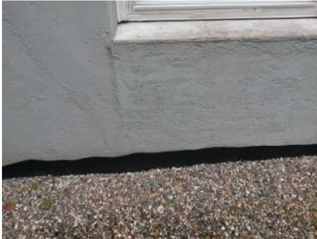
Perusmuurilevyn ylälistä puuttuu
