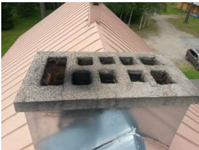
Piippu rapautunut yläosasta. Hattu puuttuu
