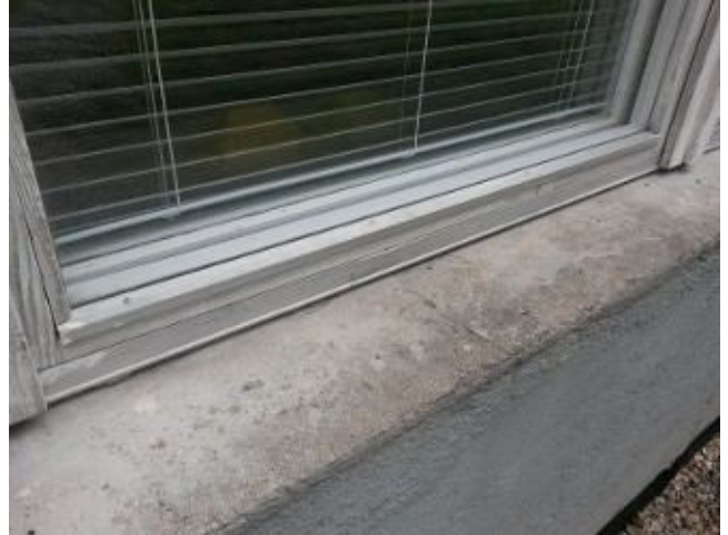
Ikkunan vesipelti puuttuu
