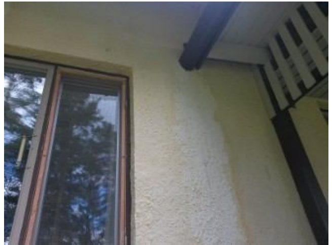
Sadevesikouru vuotanut aikaisemmin seinälle
